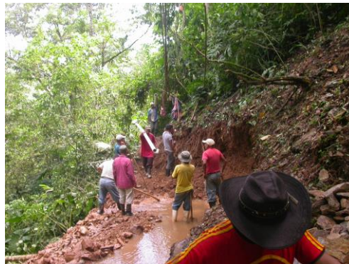
Werkzaamheden bij de bron
