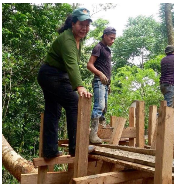
Ana bij de constructie van de distributietank
